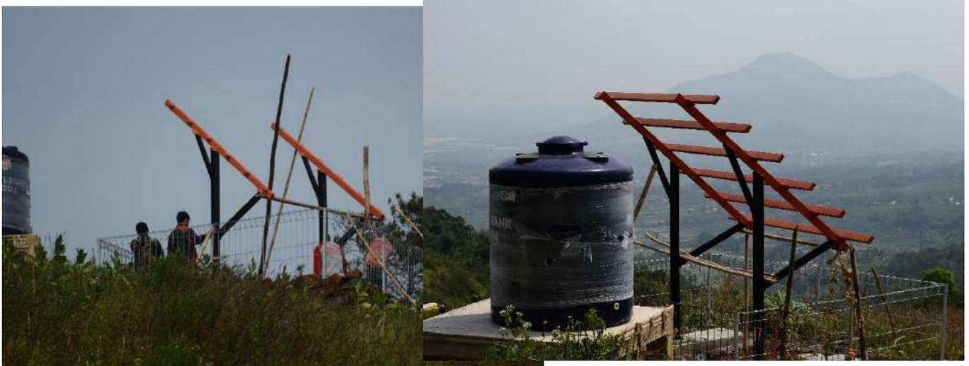
Setelah seluruh komponen tiba di puncak bukit pengerjaan dilanjutkan dengan perakitan. Perakitan pertama adalah perakitan rangka untuk menopang solar panel. Rangka di design sangat kokoh karena angin di puncak bukit sangat kuat. Setelah rangka berdiri pengerjaan selanjutnya adalah pemasangan solar panel dan inslatasi sistem kelistrikan. Pembangkit listrik tenaga surya ini bertugas untuk menyuplai energi ke pompa di embung utama dan lampu penarangan di beberapa pos penjagaan lahan.
