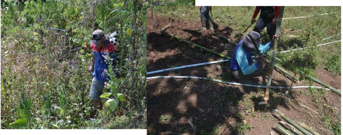
Setelah embung dan pembangkit listrik siap langkah selanjutnya adalah pembuatan bendungan dan mengaktifkan saluran air dari hutan ke embung utama dan dilanjutkan dengan memasang pipa pvc. Pipa pvc berfungsi untuk mengalirkan air dari embung utama ke atas bukit. Embung utama dan puncak bukit memiliki jarak sejauh 150 meter dengan beda ketinggian 40 meter.
