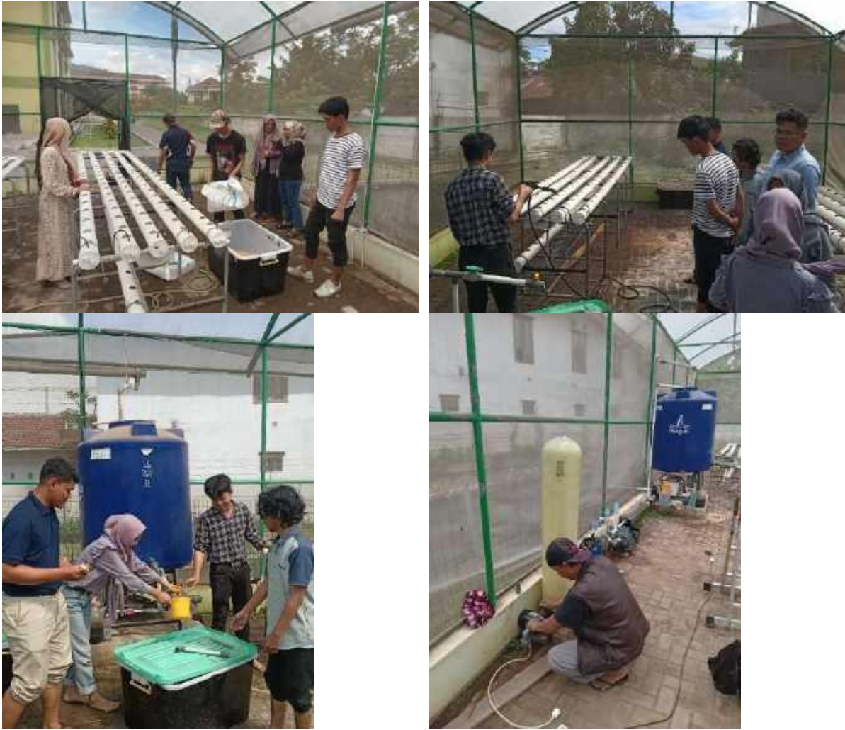
Gambar 9. Pembersihan instalasi hidroponik dan pemasangan filter air
